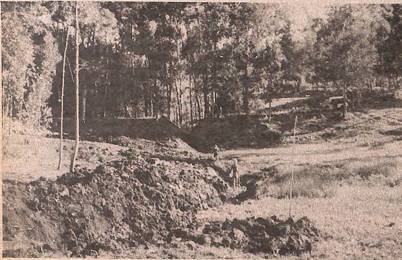
Obras de canalização para o campo de futebol sete
